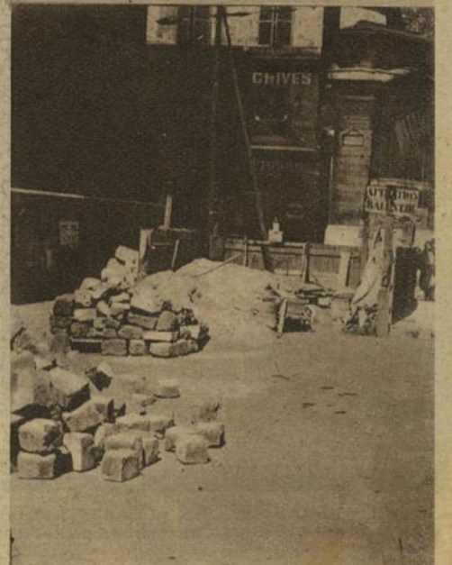
Au coin de la rue des Archives et de la rue des 4 Fils le chantier sous lequel fut trouvé la petite tête mutilée.
