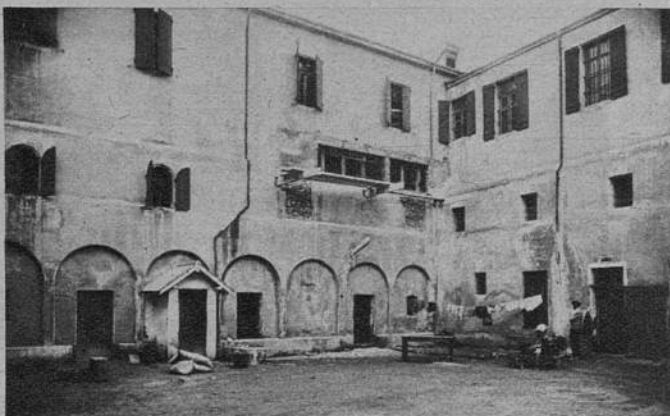
La cour principale de la prison de Perpignan, avec les échafaudages nécessités par des travaux de maçonnerie et qui ont peut-être été très utiles aux évadées. (H. M.)
