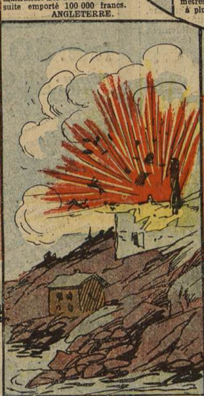
UNE CATASTROPHE. —Une usine de nitroglycérine située au bord de la mer a sauté. Plusieurs ouvriers ont été déchaquetés et leurs débris projetés dans la mer à plusieurs centaines de mètres. On compte trois morts, trois disparus et de nombreux blessés, dont plusieurs grièvement. PORT-VENDRES.
