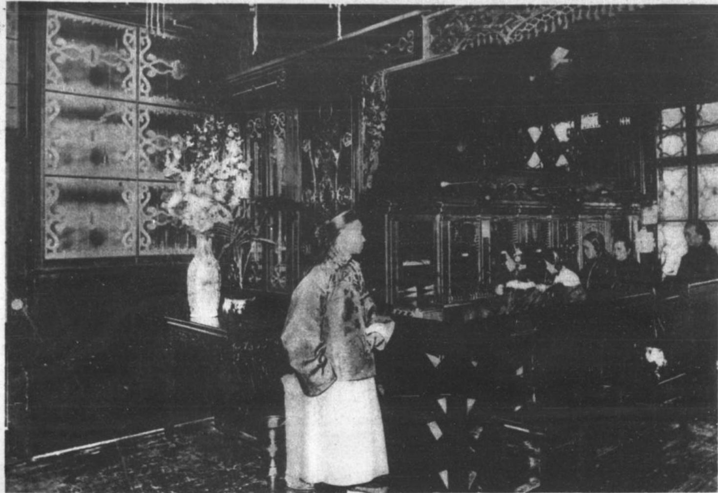
Le Central téléphonique dans le building de l'On Leong Tong.
