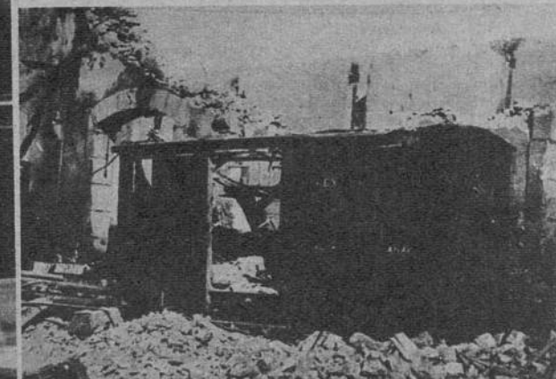
La gare des marchandises d'Annemasse a été détruite par un violent incendie. Les dégâts se chiffrent par millions. La justice recherche la cause de ce sinistre. La photo montre la gare détruite, et ce qui reste d'une rame de wagons. (W. W.)
