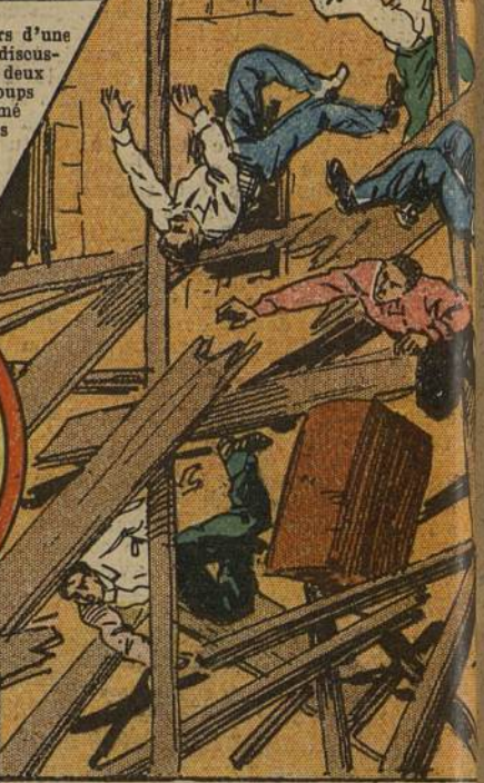
TOMBÉS D'UN ÉCHAFAUDAGE. — Boulevard Joffre, une pierre de taille qui se trouvait au cinquième étage d'une maison en construction, tomba sur l'échafaudage dont un plancher bascula. Cinq maçons furent précipités dans le vide. Ils reçurent tous des blessures graves. PARIS.
