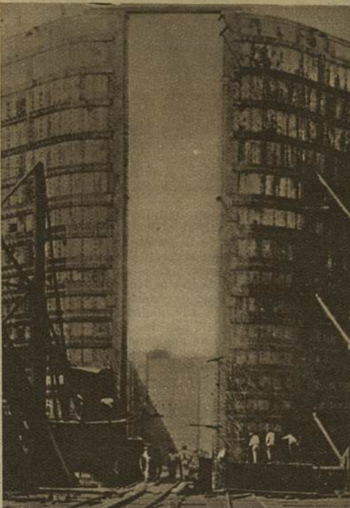
La construction d'une des gigantesques écluses du canal.
