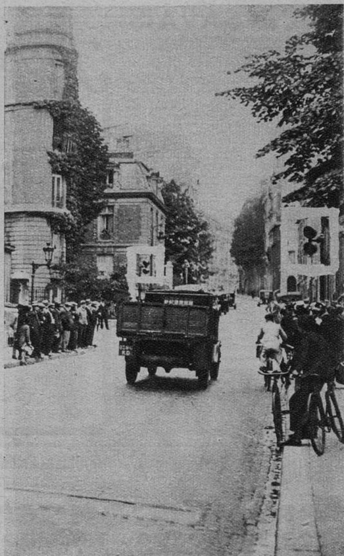
On a expérimenté, à Paris, au Ranelagh, un nouvel appareil de signalisation urbaine. Quand une voiture s'engage dans un carrefour dangereux, elle signale automatiquement sa présence aux autres véhicules par un feu qui s'allume quelques secondes à l'avance. (K.)
