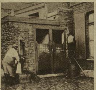
Kistiaens se réfugia dans des water-closets.
