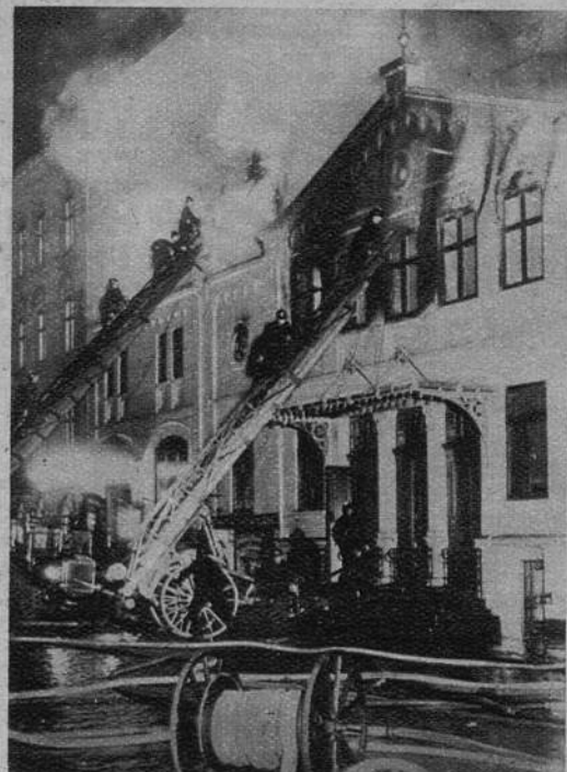
A Copenhague, le théâtre Norrebors, le plus ancien de la ville, a été détruit par un formidable incendie nocturne. Dégâts matériels élevés. (R.)
