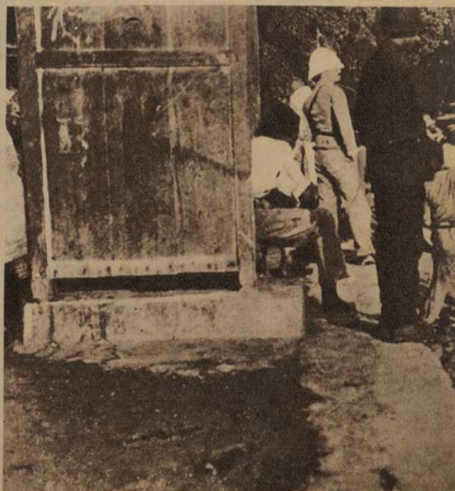
Les chantiers meurtriers de la Guyane, — ce qu'on a consommé de vies humaines, malgré le dé...
