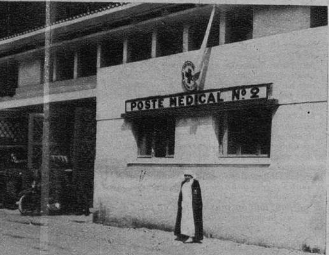
Commissariat central, le poste central des pompiers et le poste médical.
