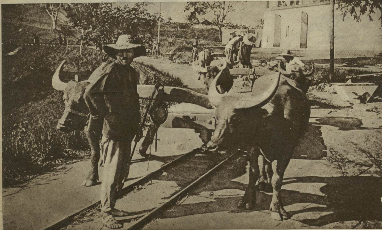
Pour les forçats qui travaillent à la construction de la route, la tentation est de toutes les minutes.
