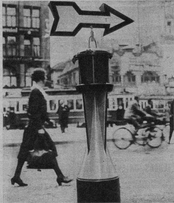
En Allemagne, pour faciliter la circulation, on vient d'expérimenter des bornes lumineuses avec signal orientable. Ce nouveau moyen de signalisation rend d'ores et déjà les plus grands services. (K.)
