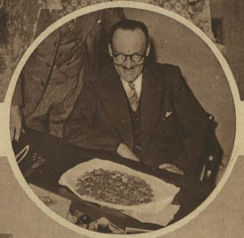
C'est dans cette bâtisse en démolition de la vieille et pittoresque rue Mouffetard, que le groupe d'ouvriers (ci-dessus) a découvert un trésor. En médaillon : le commissaire du quartier a le sourire en contemplant les pièces d'or.
