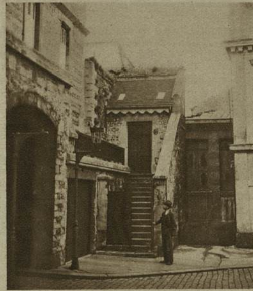
L'escalier par où Serge de Lenz parvint à descendre le coffre-fort.
