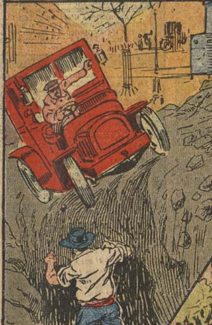
UN TAXI DANS UNE TRANCHÉE. — Avenue de la République, un chauffeur de taxi, par suite d'un coup de volant, jeta sa voiture dans une tranchée où travaillait un ouvrier. Le pauvre homme qui avait l'avant-bras gauche fracturé, se plaignait de douleurs internes. PARIS.
