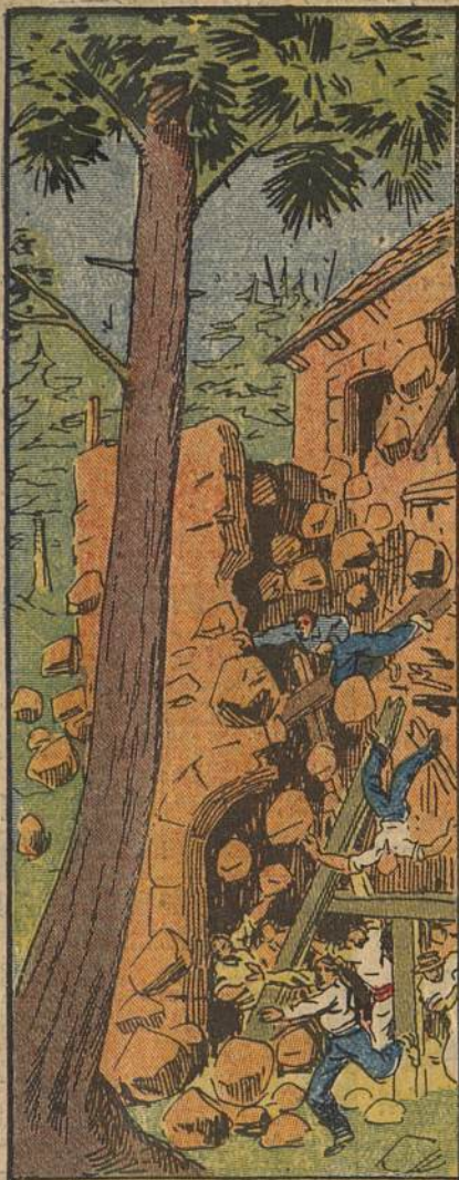
UNE VILLA S'EFFONDRE. — Une villa en construction s'est brusquement effondrée, en sevrissant les dix ouvriers occupés aux travaux. Cinq ont été tués et cinq blessés. Les cadavres des cinq victimes ont été retirés après de nombreuses difficultés. ARCACHON.
