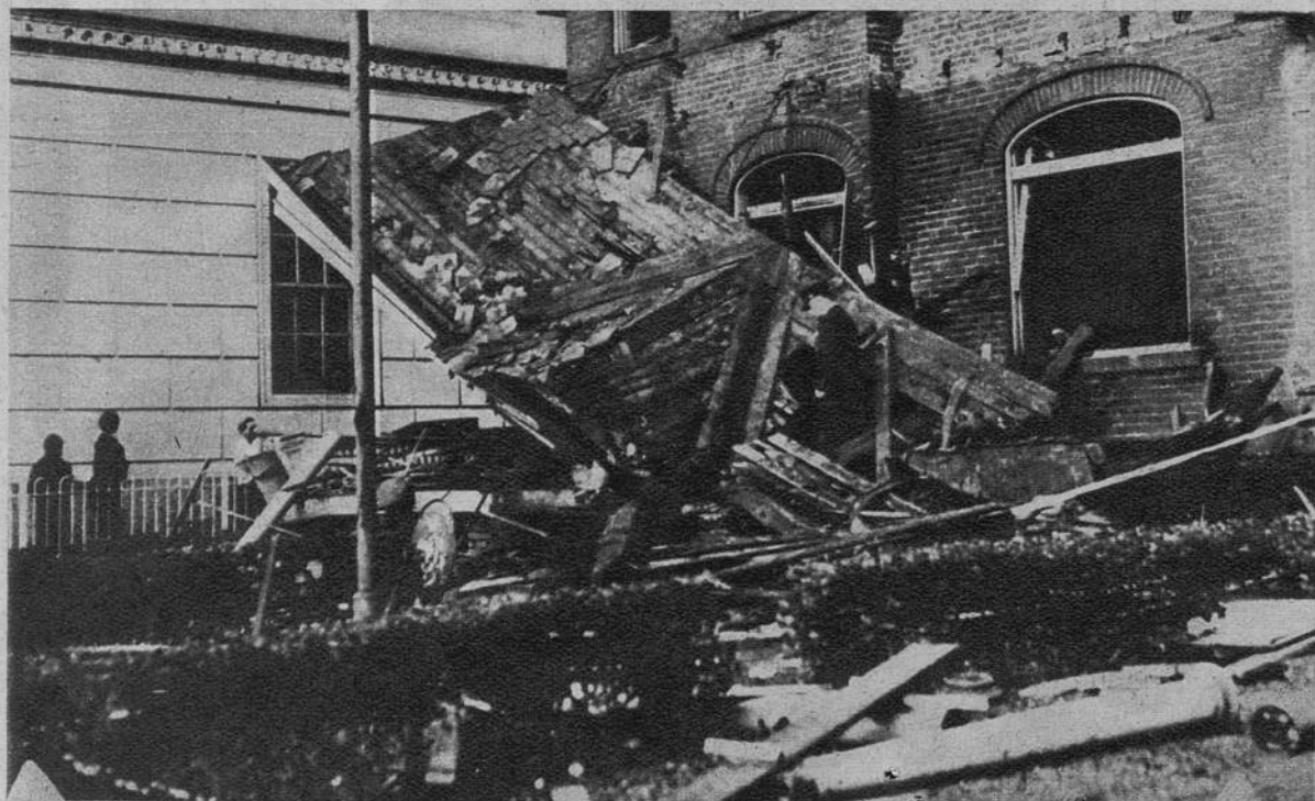
Et voici un autre aspect encore de la façade écroulée de l'immeuble. Remarquez, parmi les débris, l'écusson royal d'Italie, au pied du mât qui le supportait. (I. N.)
