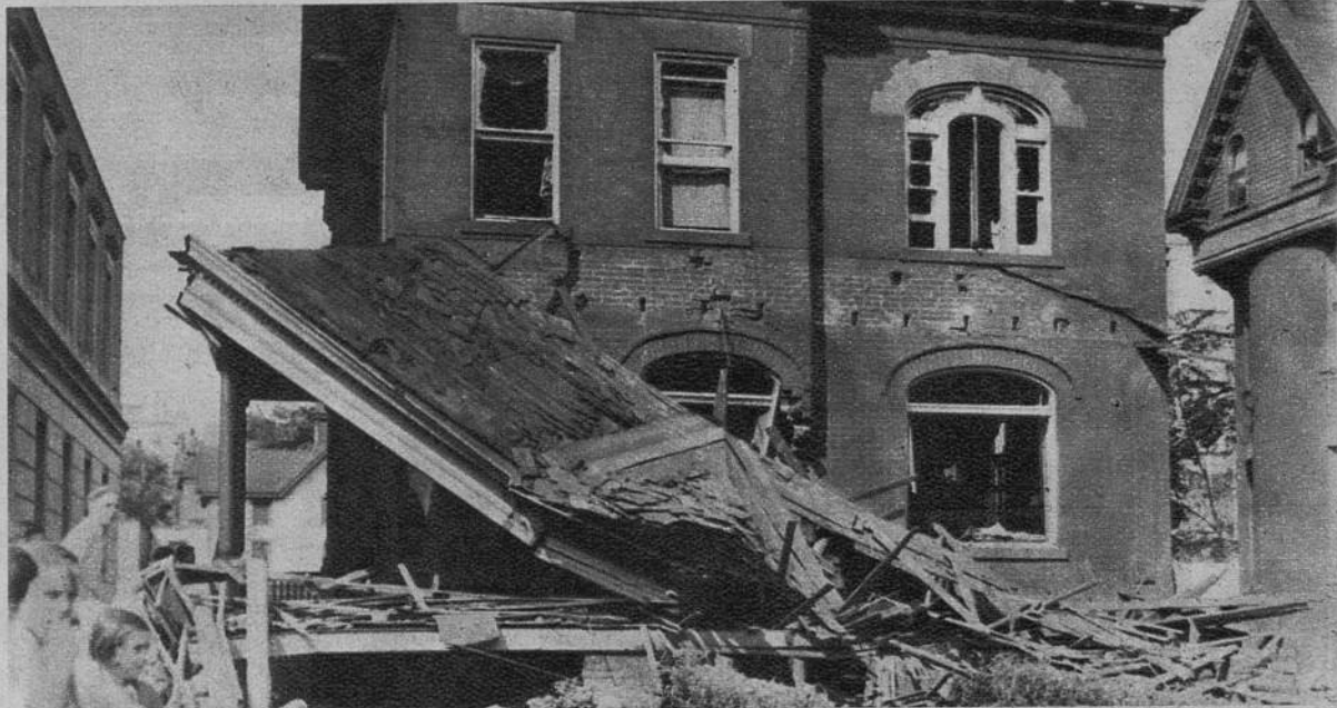
La bombe qui a fait les terribles dégâts que l'on voit ici avait été placée sur le rebord de la fenêtre centrale, sous la véranda écroulée. L'explosion fut formidable et déclencha la panique dans tout le quartier. (W. W.)
