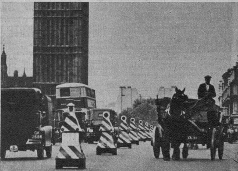
Sur le pont de Westminster, à Londres, afin de mieux canaliser les véhicules, on a placé au centre du pont et presque sur toute sa longueur de gros piliers blancs et noirs qui, la nuit, s'illuminent à leur sommet. (I. P. S.)
