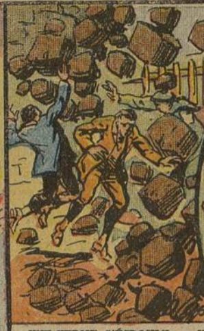
UNE FERME S'ÉCROULE. — Un enfant de 8 ans jonait en compagnie de deux autres camarades dans la cour d'une ferme de Gadonnay, quand, subitement, le vieux bâtiment servant de crèche s'écroula, ensevelissant les trois bambins.
