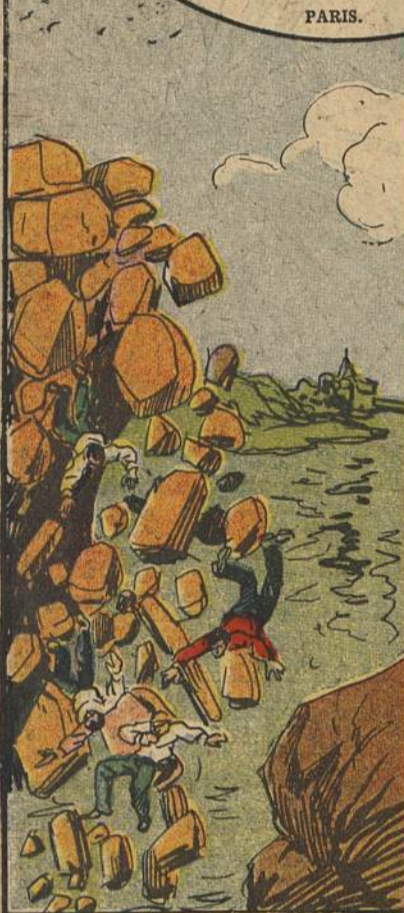
UN PONT S'ÉCROULE. — A Bonn, la dernière arche du vieux pont de l'Ahr, à Koeningen — tout ce qui restait de l'édifice — s'est effondré.
