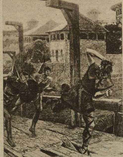
Comme Leucaste s'enfuyait sur un pont, un de ses pieds s'engagea entre deux poutres et il tomba, se cassant la jambe.
