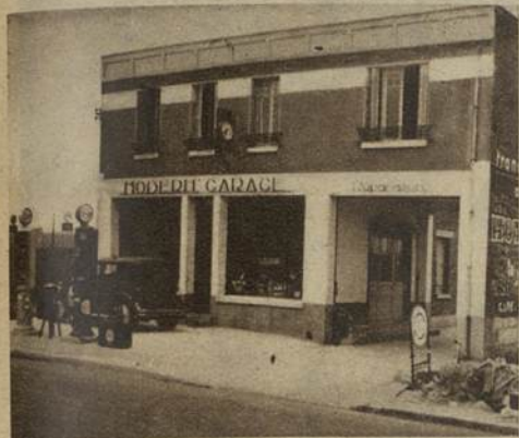
Le garage de M. Freté, où les bandits remisèrent leur auto en panne.
