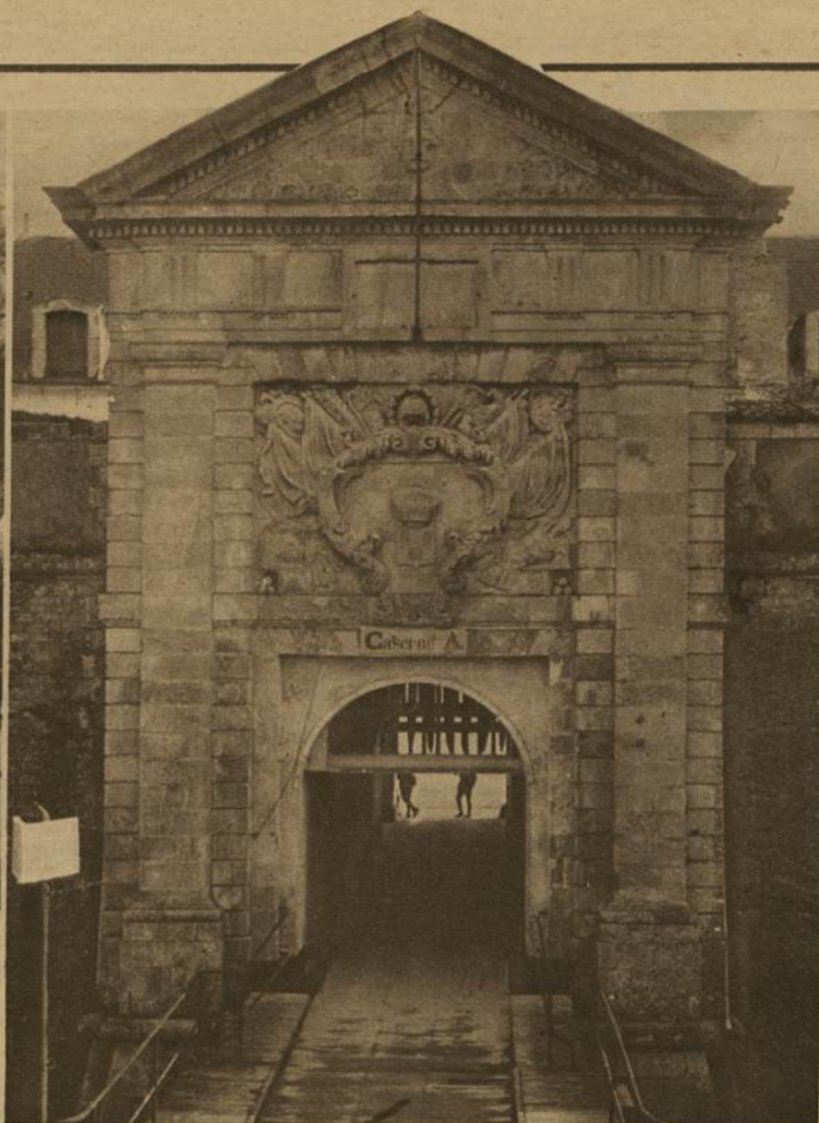
L'entrée du dépôt de St-Martin-de-Ré.
