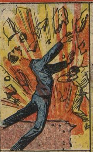
EXPLOSION DANS UNE USINE. — Un terrible accident est survenu aux ateliers des Chemins de Fer Fédéraux, à Yverdon. Une cloche à acétylène a fait explosion. Le contremaître a été littéralement décapité et un ouvrier a été transporté à l'hôpital dans un état désespéré. SUISSE.
