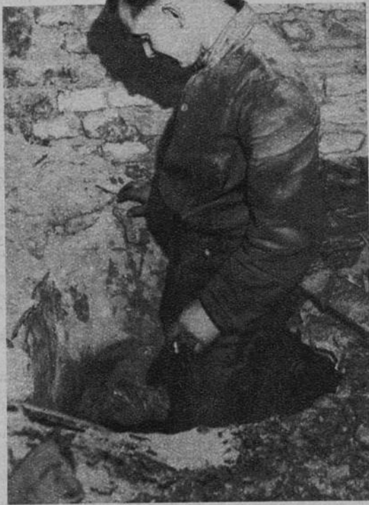
Voici, dans l'angle de la cour, l'entrée du souterrain par lequel se glissèrent les cambrioleurs. De là, ils gagnèrent la cave voisine et, trouant les cloisons de brique, ils arrivèrent jusque sous le magasin du joaillier. (W. W.)
