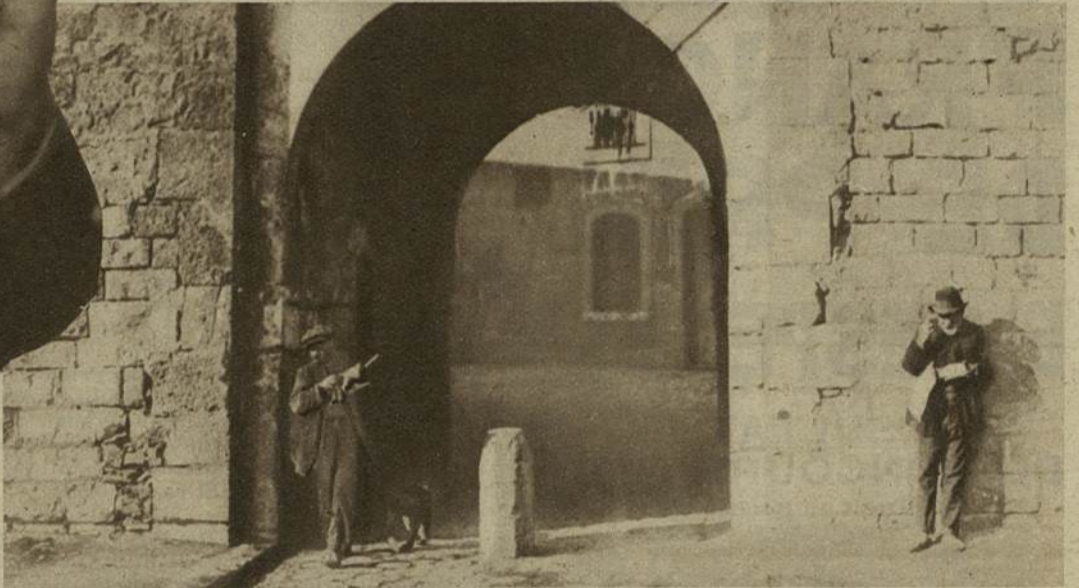
Par delà les voûtes, au fond de ruelles sombres...
