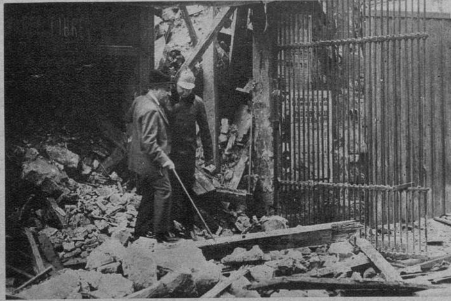
Une maison s'est écroulée rue Mouffetard pendant que trois ouvriers étaient occupés à en démolir la façade. Pris sous les décombres, ils ont pu être dégagés à temps et n'ont été que légèrement atteints. (R.)
