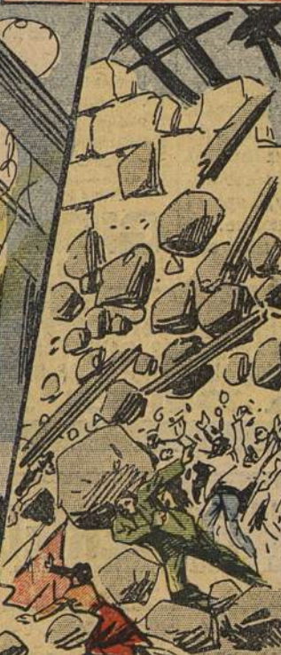
UNE FILATURE S'EFFONDRE. — A Bühl, près de Mulhouse, une partie d'une filature s'est effondrée pour des causes non encore élucidées. Il y a quatre morts : deux hommes et deux femmes, et seize blessés. On craint qu'il n'y ait d'autres victimes sous les débris. ALSACE-LORRAINE.
