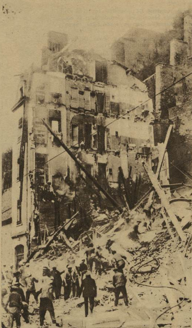
Minée par les pluies et par les courants d'eau souterrains une partie de la colline de la Croix-Rousse venait de s'écrouler avec un fracas épouvantable.
