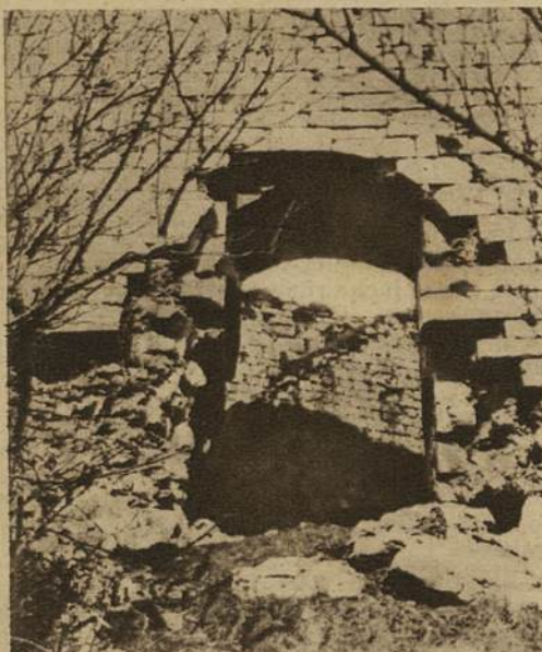
Vandales, les montagnards arrachèrent au porche d'entrée des pierres à bâtir.
